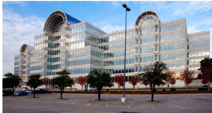
Equinix DA6 IBX data center exterior
